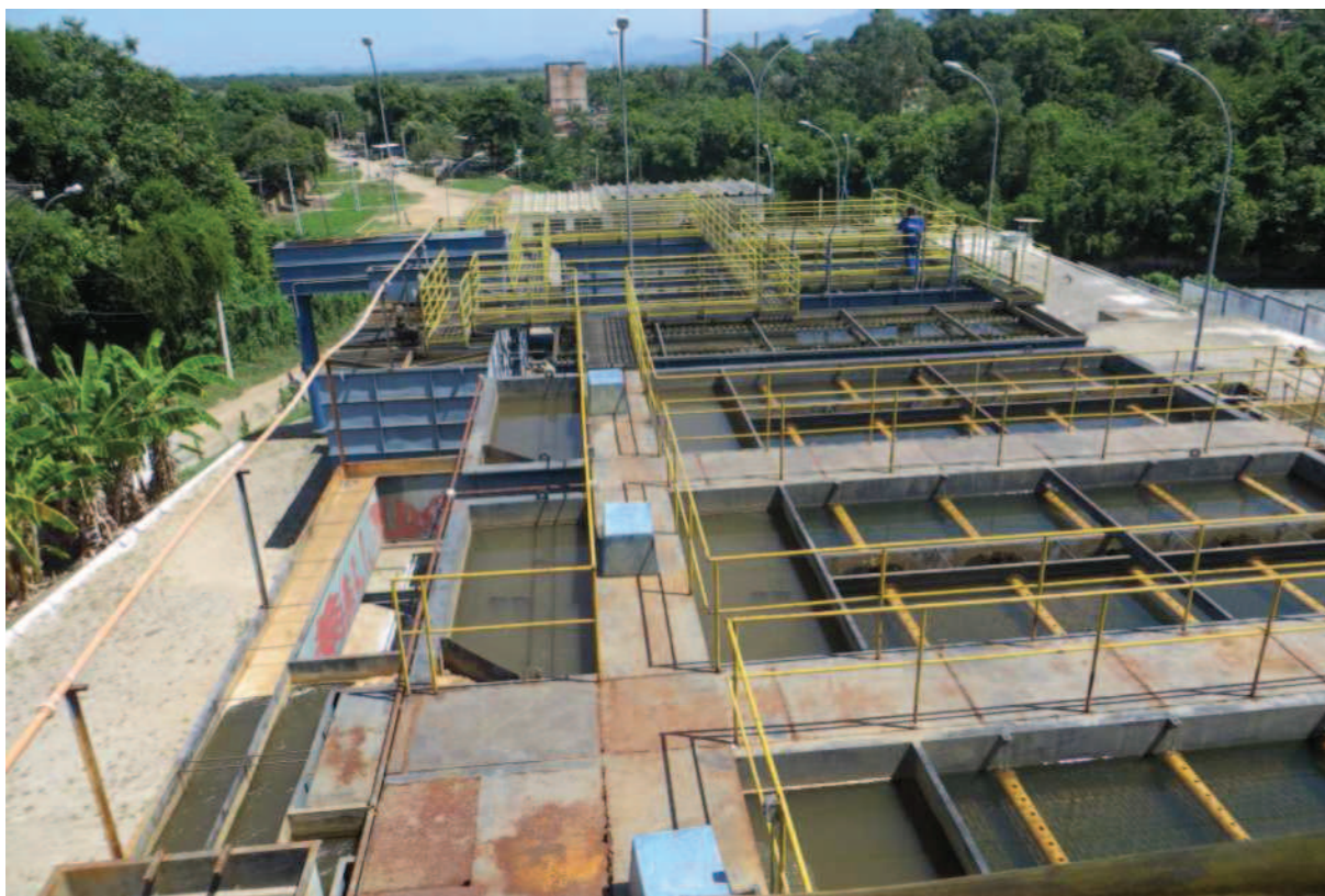
Figura 21 - Vista da ETA Porto das Caixas
